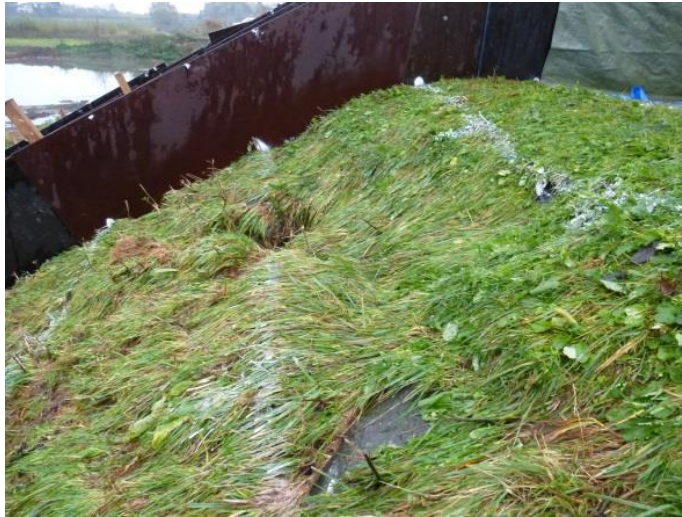
Figuur 2.13 Golfoverslagproef op steil talud en schade bovenaan bij de kruin [16].
