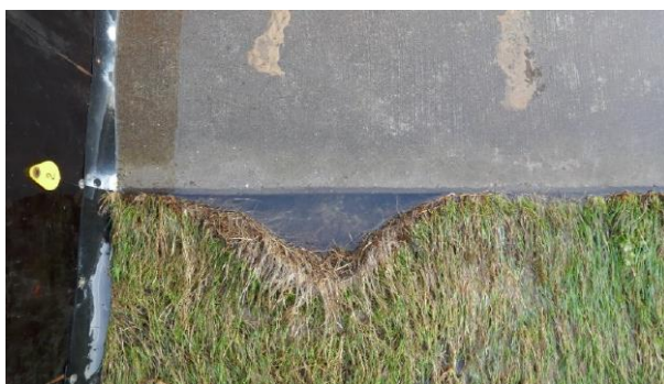
Figuur A.8 Strook 1, overgang betonpad en grasbekleding eind van de proef.
