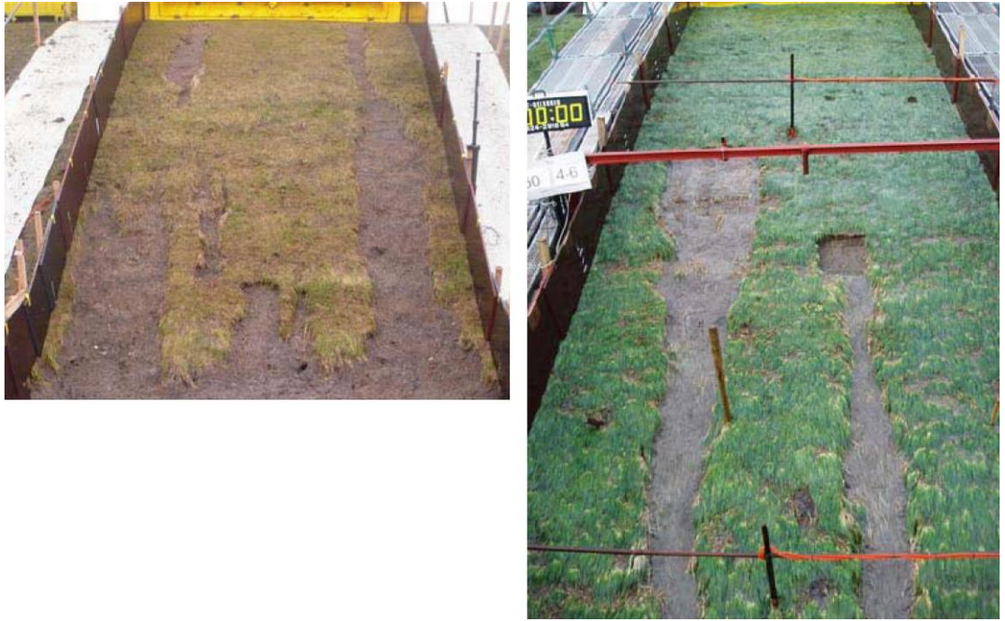
Figuur 2.2 Afstropen van de zode (links Afsluitdijk, rechts Delfzijl na aanbrengen van schades).
