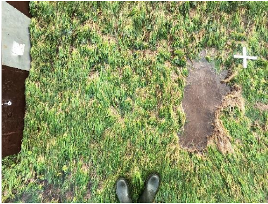
Figuur A.5Schade onderaan het talud strook 1-1b.
