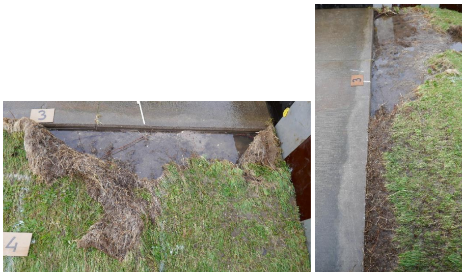
Figuur A.11 Strook 4, schade overgang betonpad naar gras na 5 uur GO1 (links) en 2 uur GO50 (rechts).
