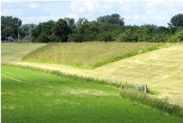
Figuur 10 Gefaseerd maaien in het gebied van Waterschap Rijn en IJssel, hier wordt een deel van de vegetatie overgeslagen tijdens elke maaibeurt (Faunavriendelijk dijkbeheer en faunaverrijkende maatregelen. Aanvulling op Handreiking grasbekleding 1.0, 2017)
