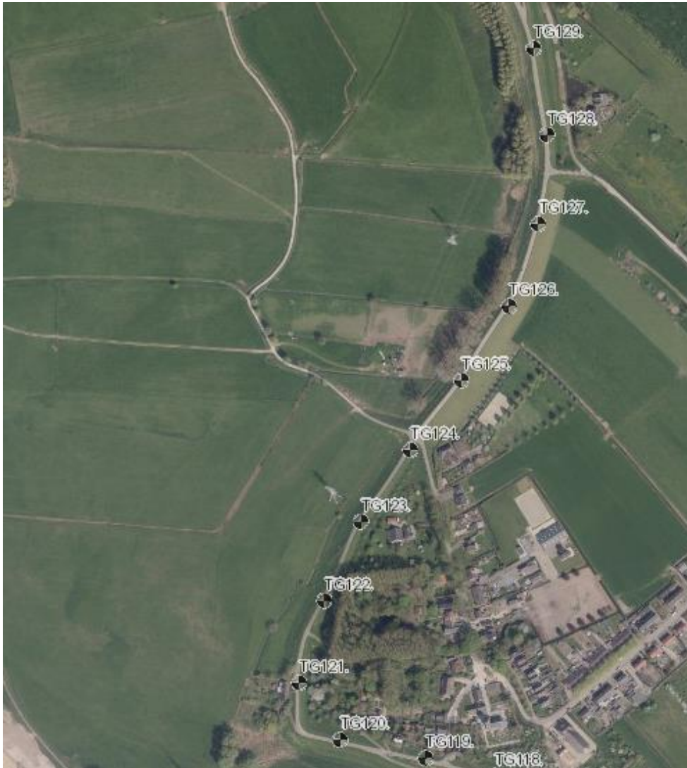
Figuur 26 Luchtfoto van een deel van het beschouwde dijkperceel in de buurt van Heesselt
