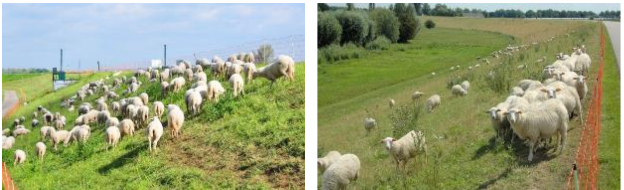
Figuur 7 Links korte intensieve beweiding met schapen, rechts effect van beweiding met schapen op de vegetatiestructuur (Handreiking grasbekleding, 2019d)
